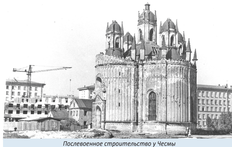
Послевоенное строительство у Чесмы
