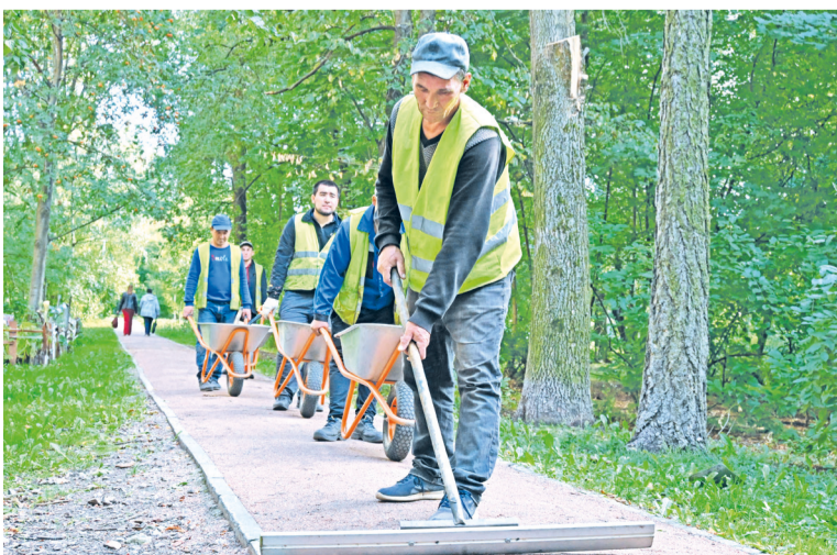
Обустройство пешеходных дорожек на территории МО Звёздное
