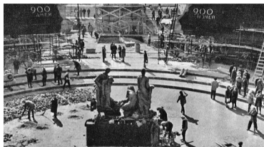
Строительство монумента «Героическим защитникам Ленинграда», 1974-1975 гг.
