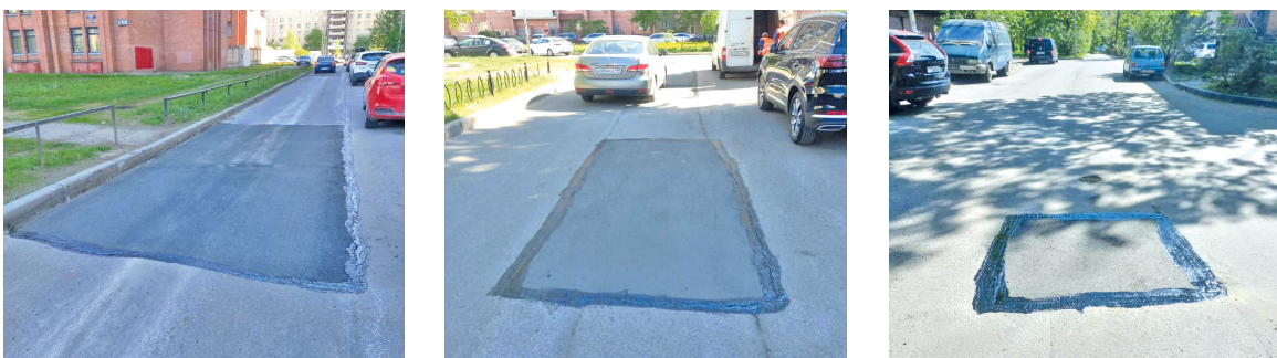
В течение лета 2023 года МО Звёздное провело ямочный ремонт дорожного покрытия по десяти адресам
