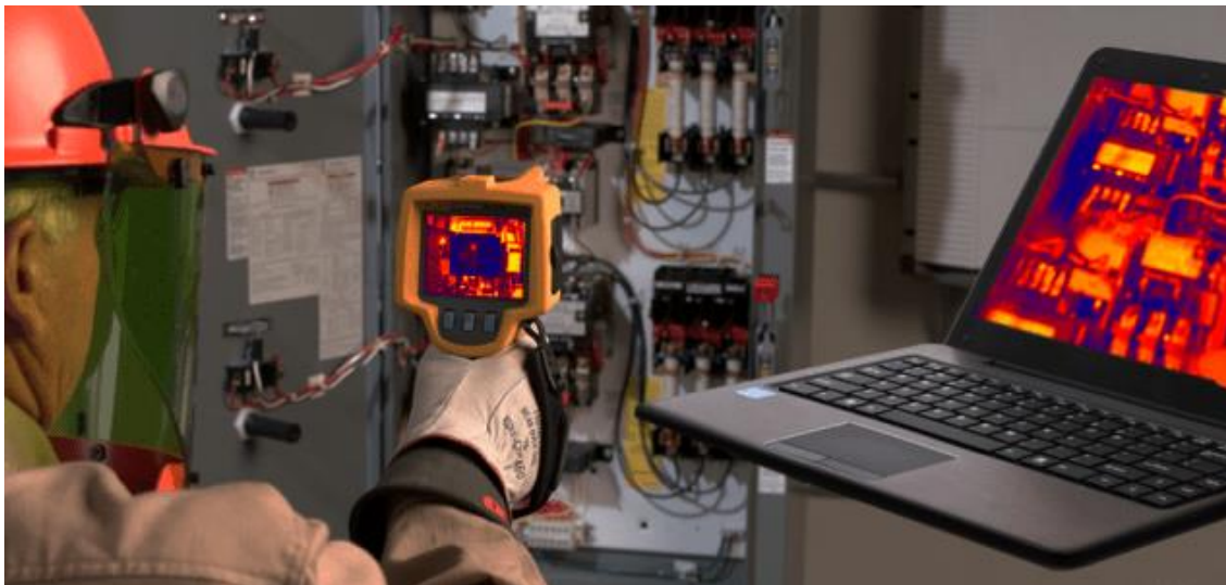
Рисунок 20. Пример проведения тепловизионного контроля электрошкафа
